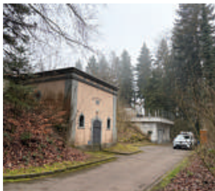
Das alte und neue Reservoir der Wasser- und Elektrizitätswerk Steinhausen AG im Steinhauser Wald.
