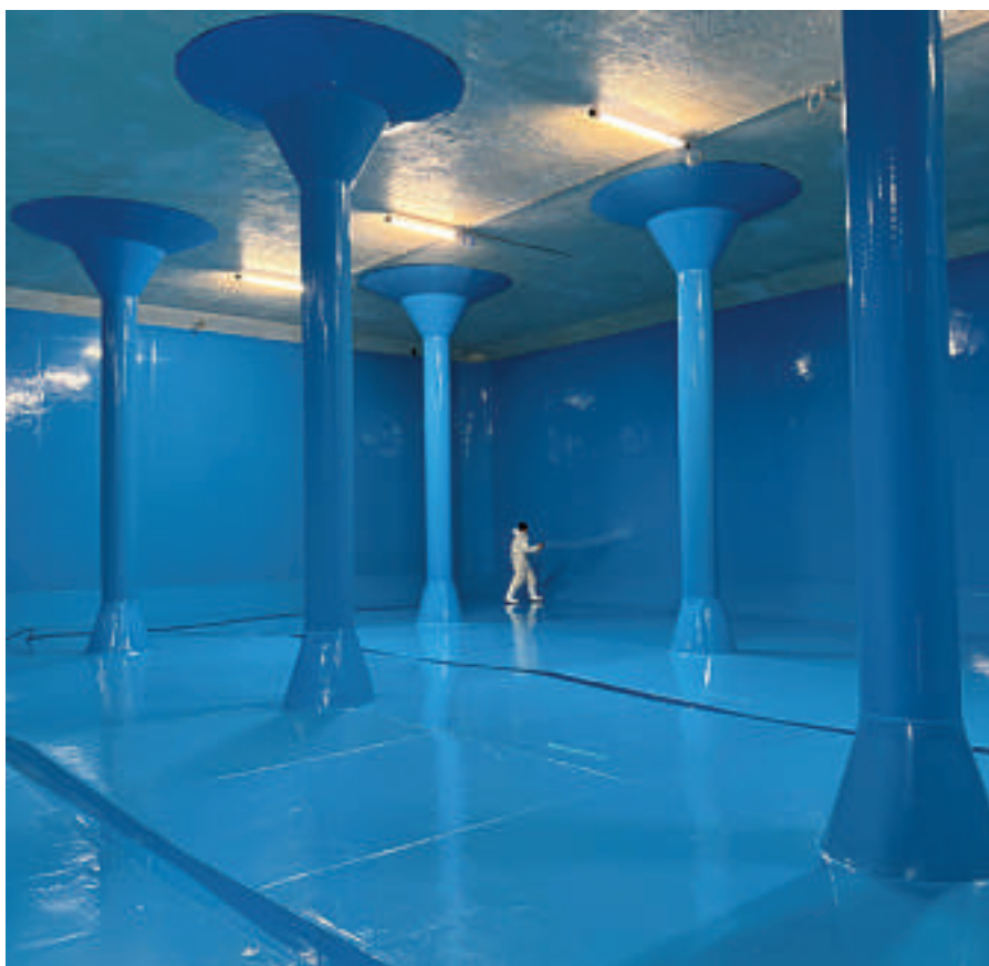
Eindrücklicher Einblick ins Innere des Reservoirs: Im Hintergrund Toni Hegglin von der Wasser- und Elektrizitätswerk Steinhausen AG bei den jährlichen Reinigungsarbeiten.
