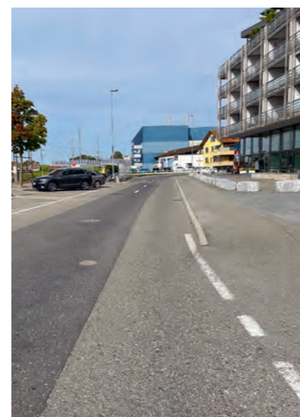
Nebst dem Bau der Bushaltestelle wird beim Bahnhof auch der Belag innerhalb des Bauperimeters saniert.
