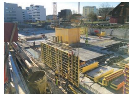
den die Erschliessungsbereiche der Häuser mit den Treppen und dem Liftschacht betoniert. Zeitgleich zu den Bauarbeiten vor Ort bereiten die Zimmerleute in der Werkstatt ihre Holzelemente vor. Sobald der erste Treppenhausturm aus Beton fertig gestellt ist, können die vorfabrizierten Holzelemente aufgerichtet werden.
