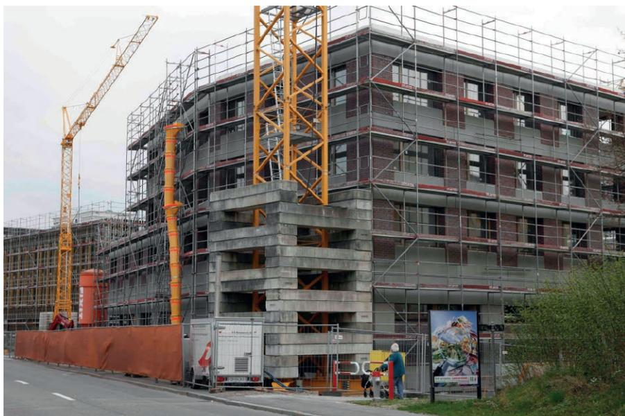
Die Klinkerfassaden-Elemente beim Gebäude mit dem neuen Coop und den Alterswohnungen sind montiert.
