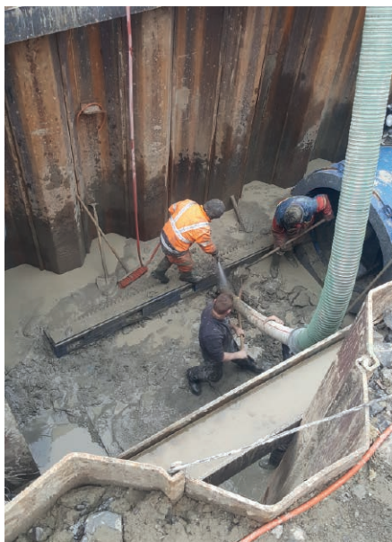
Ausfliessendes Bodenmaterial aus dem Pressvortrieb in die Startgrube
