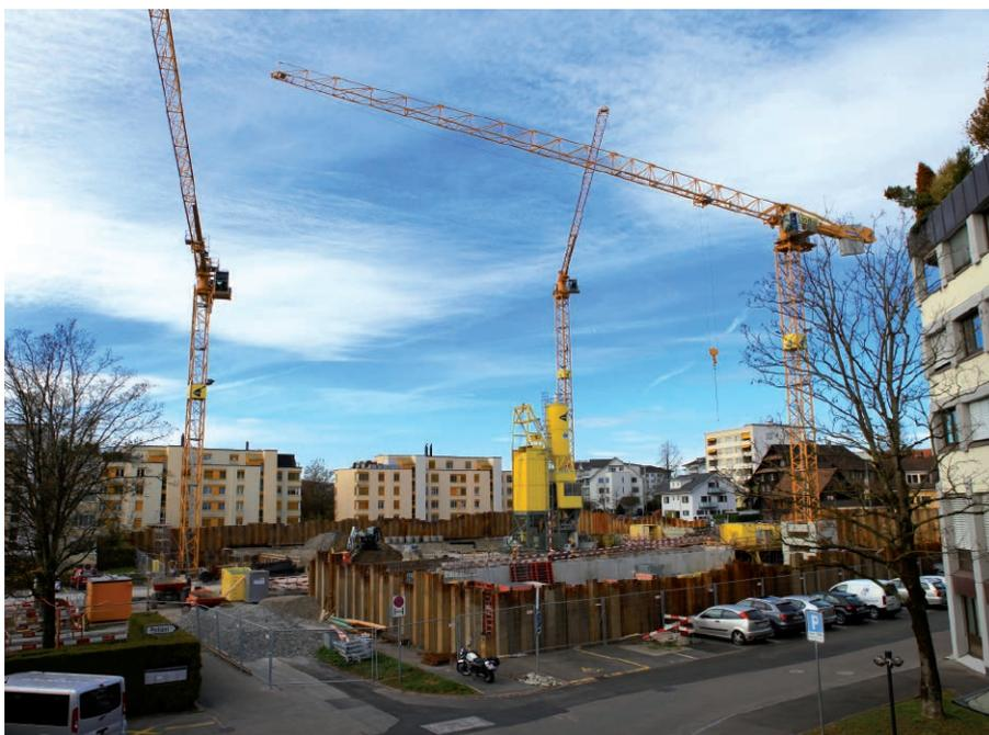
Inzwischen stehen alle drei Baukräne und im Betonmischerturm wird am Ort Beton in verschiedenen Qualitäten produziert.
