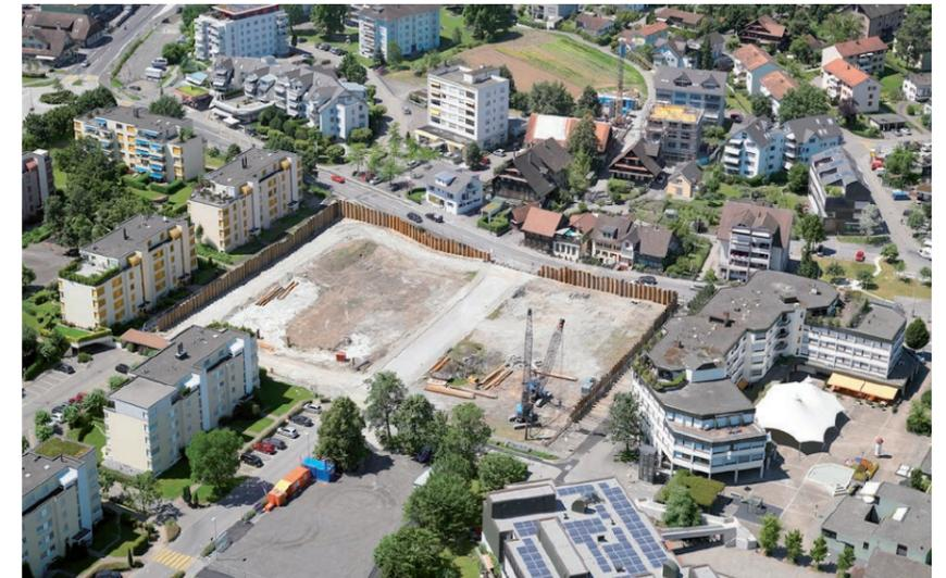
Die Spundwände sichern die Baugrube, auch wenn sie höher als üblich aus dem Boden ragen. Luftbildaufnahme © Flying Camera
