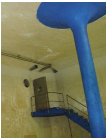
Vor der Renovation: Eingangsbereich mit Treppe.
