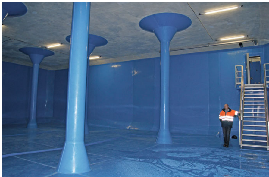
Eindrückliches Bild nach der Komplettsanierung im Reservoir 2.
