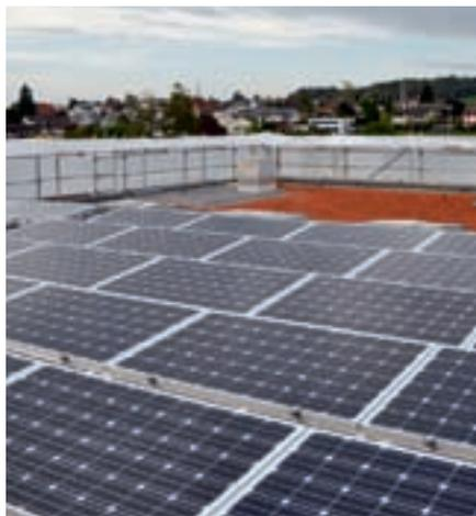
dem Dach zusätzlich zu allen bautechnischen Massnahmen eine grosse Photovoltaikanlage installiert. Der produzierte Strom wird ins Energienetz eingespeist. «Im Internet kann die Steinhauser Bevölkerung verfolgen, wie viel Strom gerade produziert wird. Zudem wird im Schulhaus auf einem Bildschirm angezeigt, wie viel Strom erzeugt wird», erklärt Hauswart Felder.
