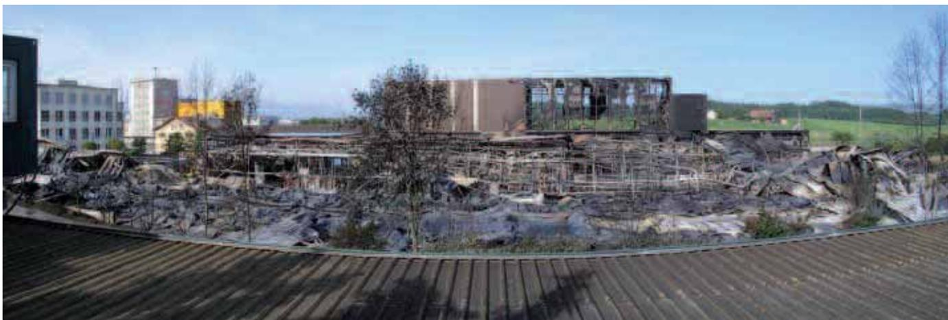
Übrig blieb nur noch Beton und verkrümmte Stahlträger und Dachbleche.
