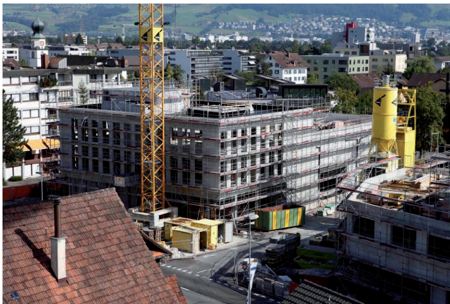
Vom Gebäude mit dem künftigen Mehrzweckraum und der neuen Gemeindebibliothek grüsst bereits das Aufrichte-Bäumchen. Jetzt beginnt der Ausbau. (Bild: V. Zoller)
