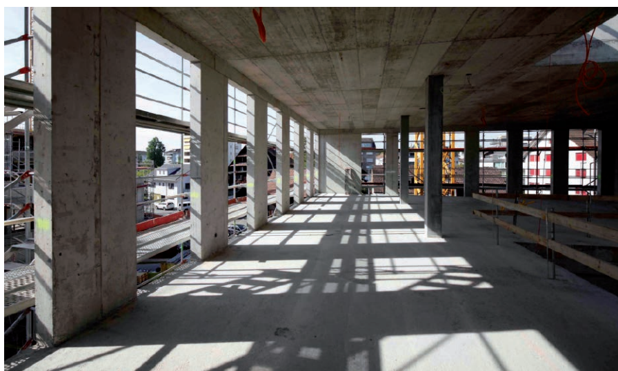
Ein Blick ins Innere des Rohbaus. Hier wird dereinst die Bibliothek zum Schmökern einladen. (Bild: V. Zoller)
