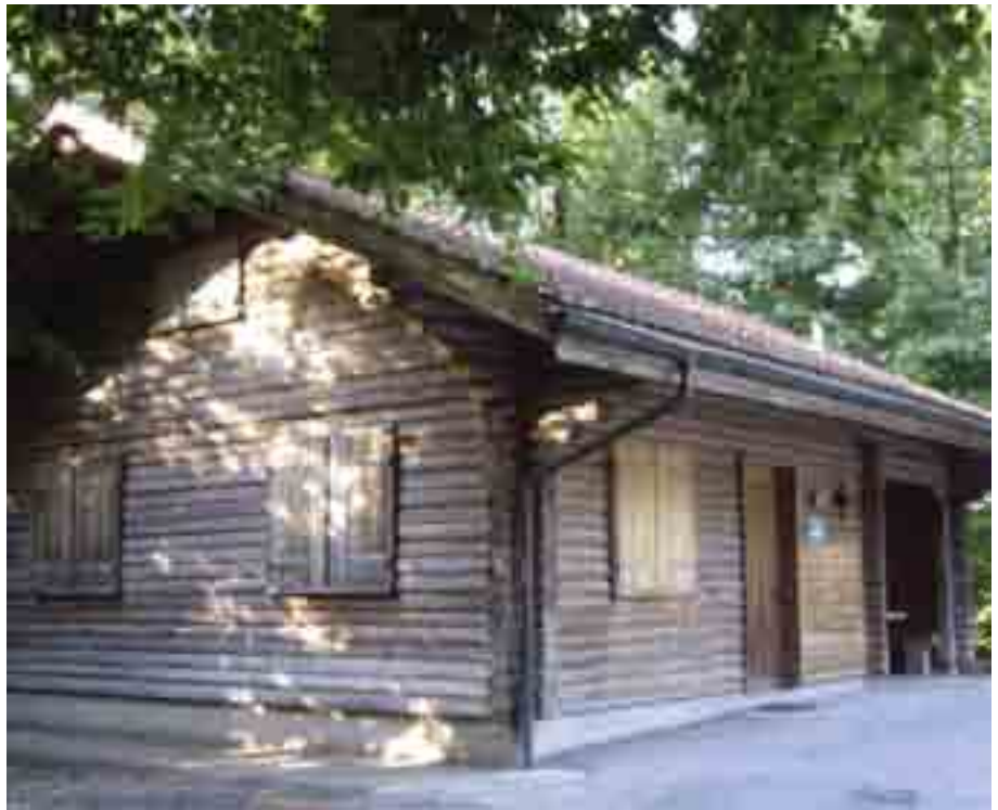
Waldhütte der Korporation Uerzlikon, pro Tag Fr. 100.– ; gegenüber entsteht zur Zeit in Fronarbeit der Korporationsbürger ein Holzschnitzzellager, wo auch Private ihre Schnitzelvorräte einlagern können
